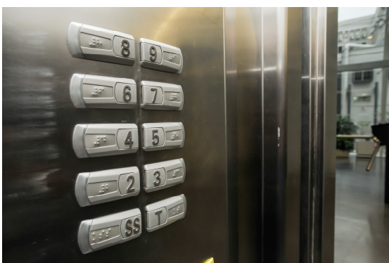
Elevadores com identificação em braile nas botoeiras
