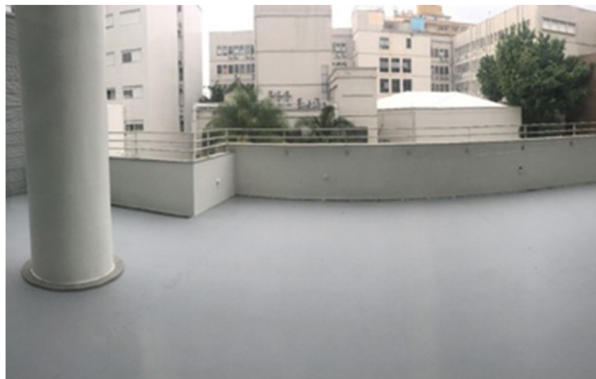
Figura 89 - Registro da revitalização da laje do Prédio 2
