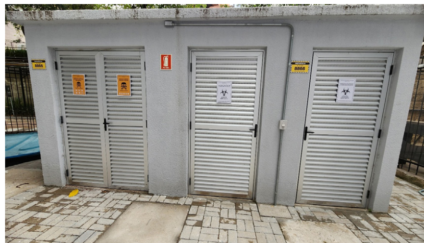
Figura 97 - Central de Resíduos Grupos A, B e E da UFCSPA
