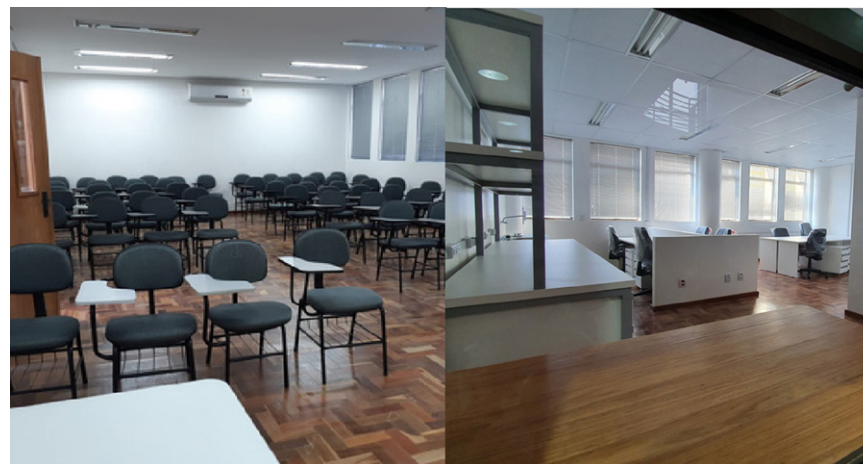
Figura 83 - Registro da reforma de pavimentos do Prédio 1
