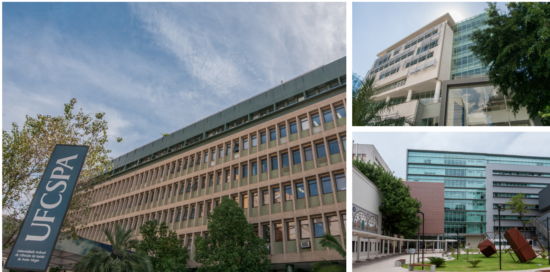
Figura 7 - Edifícios e Praça dos Cubos da UFCSPA.
