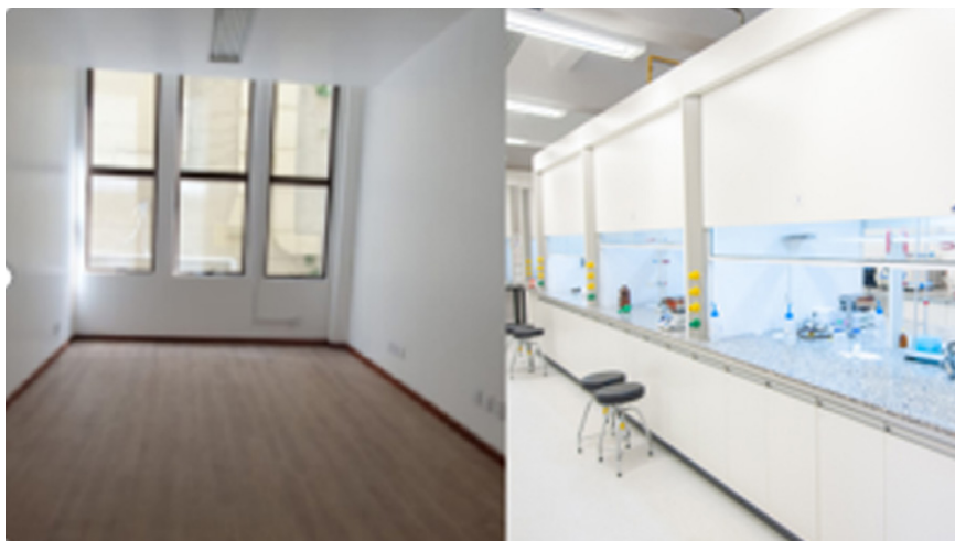
Figura 84 - Registro de reforma de salas de aula e laboratório do Prédio 1
