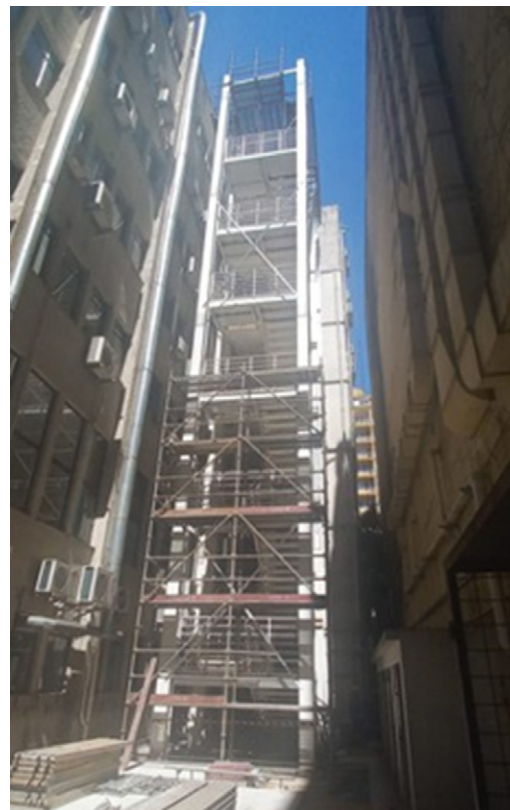
Figura 91 - Registro da execução do PPCI do Prédio 1
