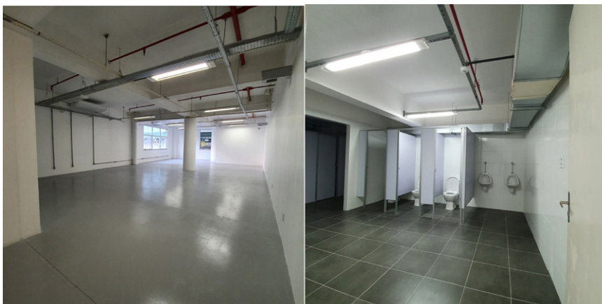
Figura 82 - Registro da reforma de pavimentos do Prédio 2
