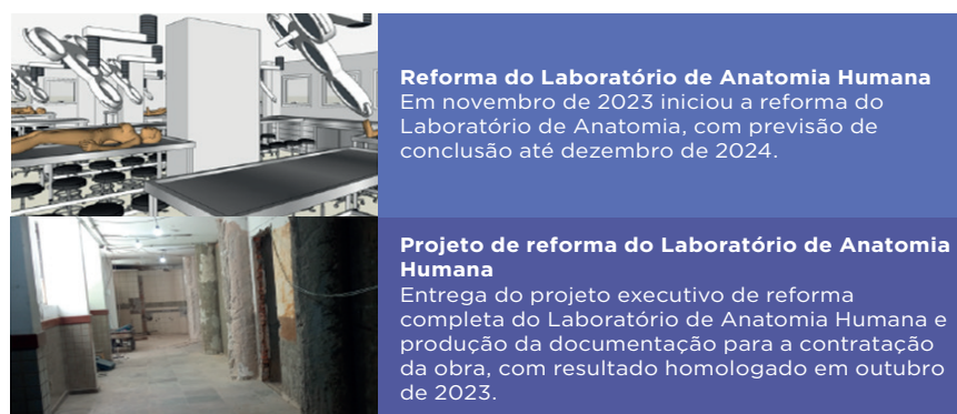
Figura 51 - Obras e reformas que iniciaram em 2023 que serão concretizadas ou continuadas durante o exercício de 2024
