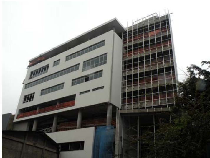
Ação: construção do anexo 2
