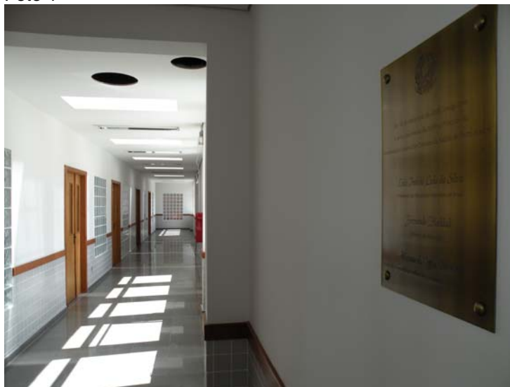
Ação: construção do sexto andar do prédio principal
